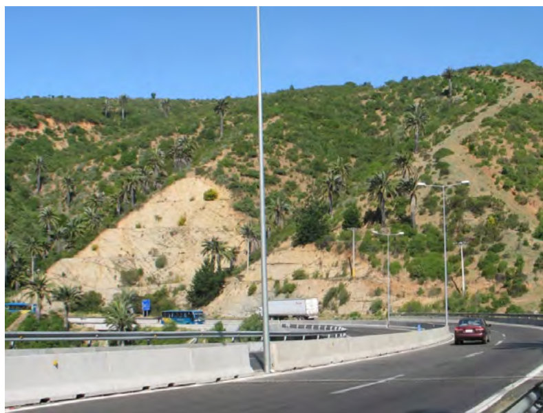
Imagen 1. La construcción de carreteras disectando las colinas eliminó numerosas palmas
