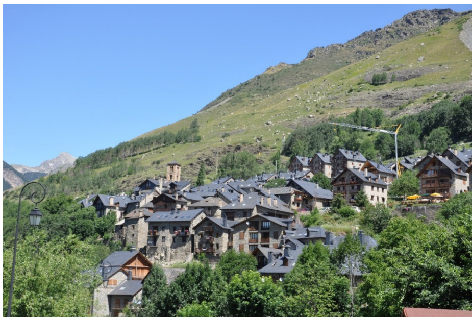
Figura 1. Núcleo de Taüll (Alta Ribagorça) con viviendas rehabilitadas y de nueva construcción
