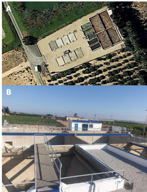
Figura 6. (A) EDAR Doña Pepa antes de su transformación. (B) EDAR Doña Pepa después de la remodelación a depósito anti-DSU
