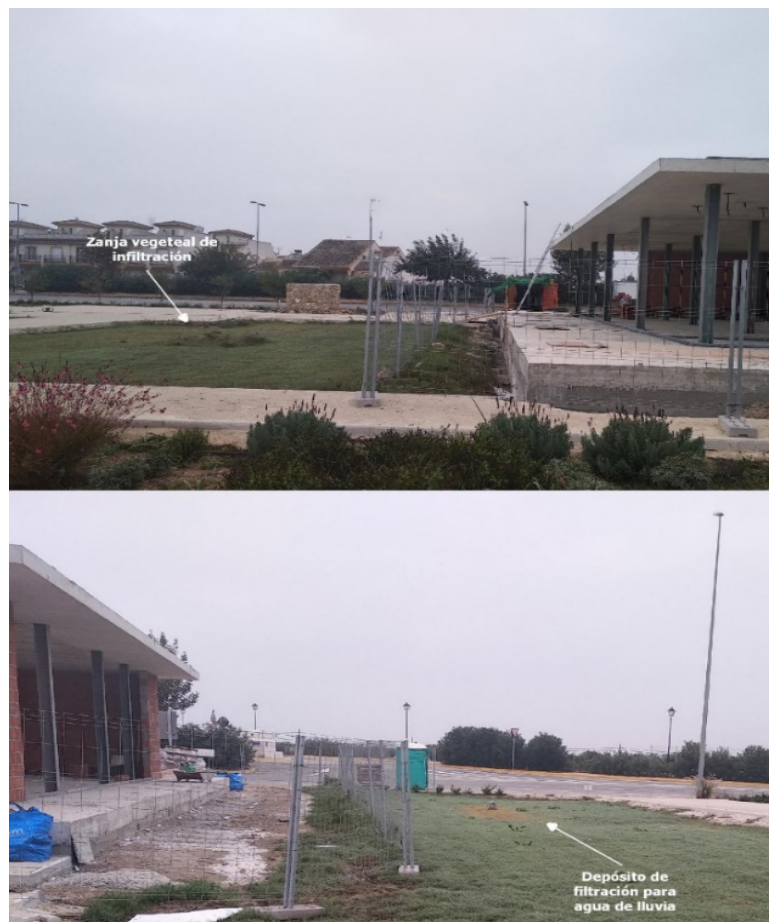
Figura 8. Zanja vegetal de infiltración y depósito de filtración para agua de lluvia
