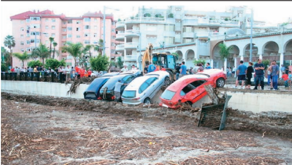
Foto 5. 21/09/07. El Acueducto de La Carrera en Almuñécar completamente cubierto por las aguas. Varios vehículos fueron arrastrados hasta el interior del foso monumental
