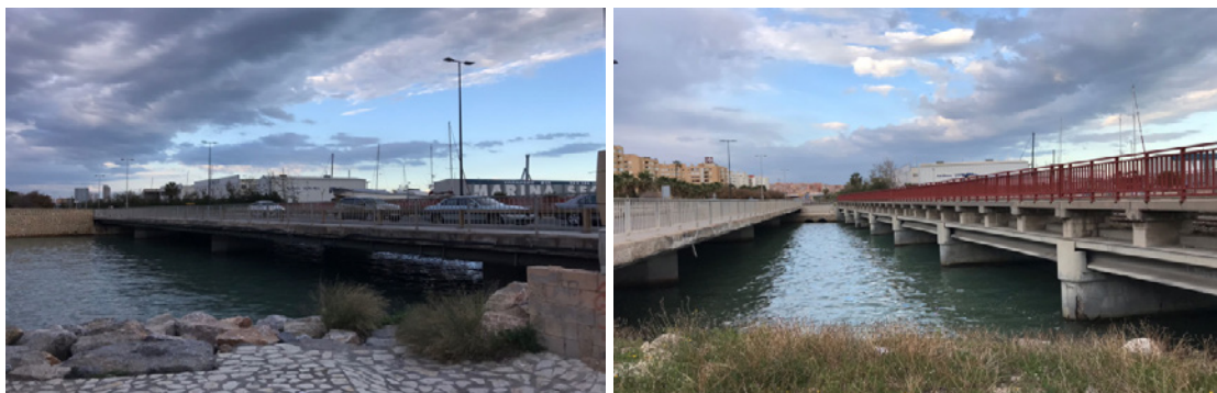
Figura 10. Carretera N-332 y vía férrea Alicante-Murcia a su paso por la desembocadura del barranco de las Ovejas.
