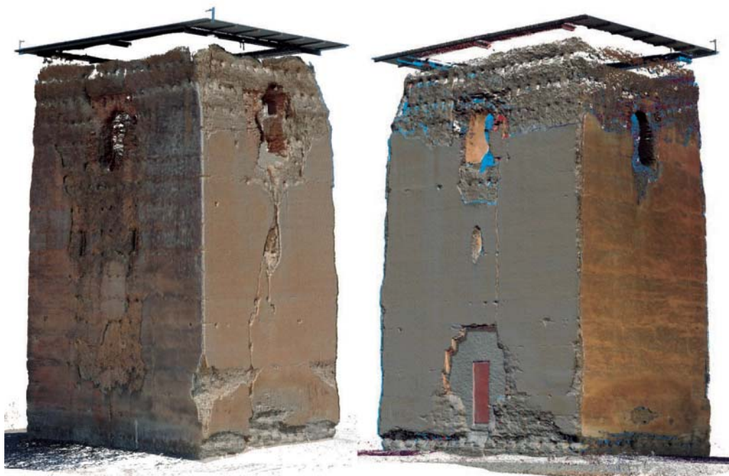
Fig. 6.—Vista de dos laterales de la torre utilizando tres escaneos terrestres, mostrando el estado actual de conservación y el tejado moderno instalado para preservar la estructura.
