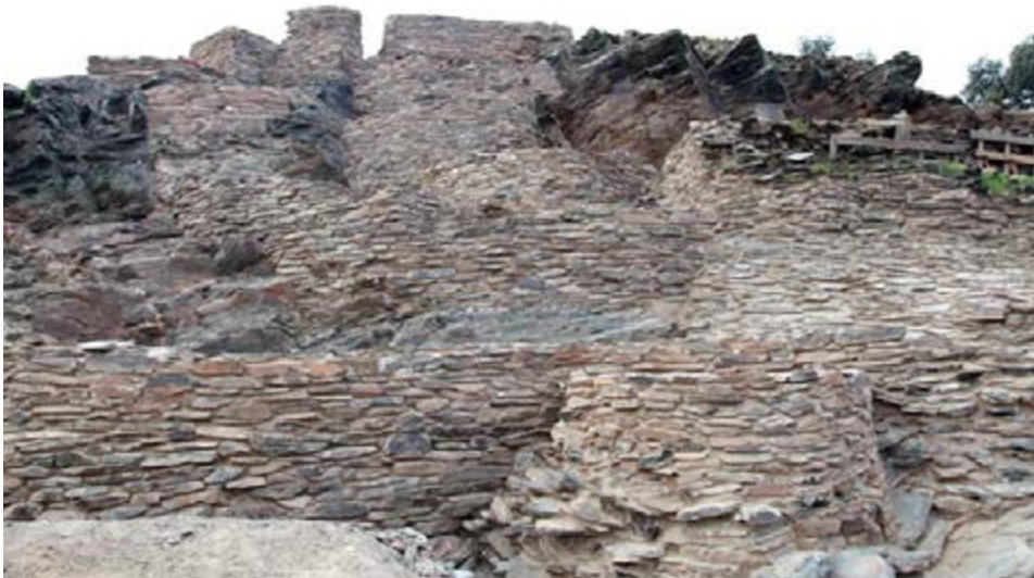
Lám. XXI.—Uno de los bastiones de la fortificación norte más exterior.
