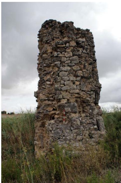
Lám. IV.—Pilar del *venter* del sifón de los Arquillos en el arroyo de Salado de Paterna, 2011.
