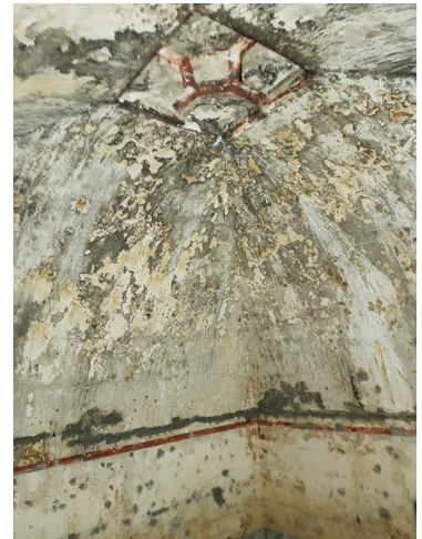
Fig. 18. Bóveda esquifada con espejo de la etapa nazarí de la torre intermedia de la barranquera. (C. Vílchez. 2024).
