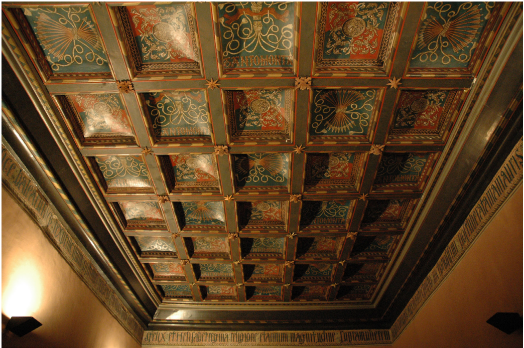
Fig. 3a. Forjados reticulares de madera con bovedillas de obra en las salas adyacentes a la Sala nueva o del trono del palacio de la Aljafería de Zaragoza. Fotografías del autor.
