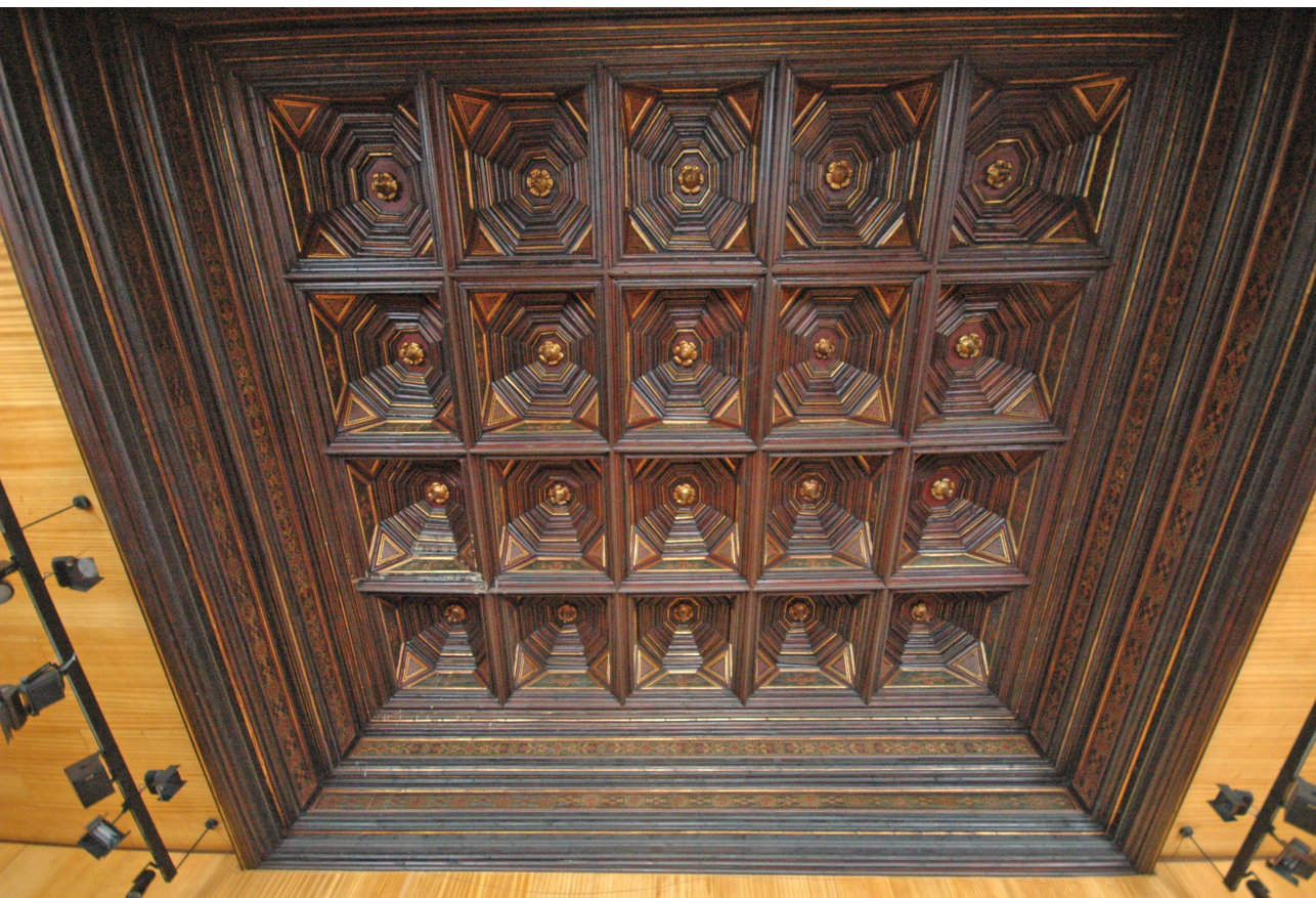
Fig. 2. Detalle de techumbre procedente de las casas de Gaspar de Ariño, hoy reinstalada en el Salón de comisiones del Ayuntamiento de Zaragoza. Fotografía del autor.
