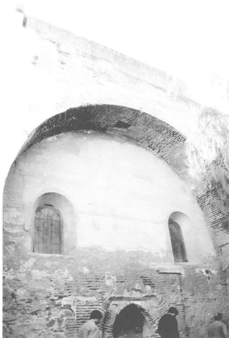
2.—Iglesia mayor de Motril. Hastial del templo, con un ladrón defensivo y una puerta semitapiada.
