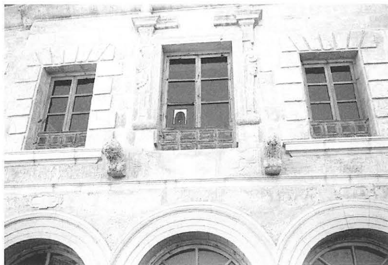
5. Ventanal central de la Casa de Oficios, podría funcionar como balcón ceremonial. Detalle fachada Casa de Oficios.
