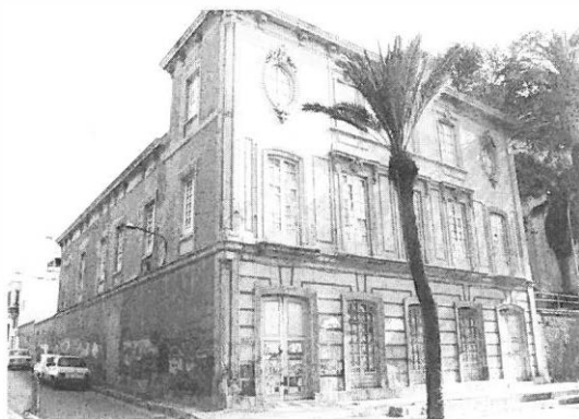
4. La Casa de D. Fernando Roda en Almería.
