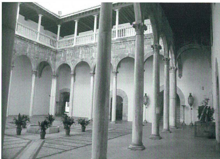
4. Patio de los Mármoles. Hospital Real de Granada.
