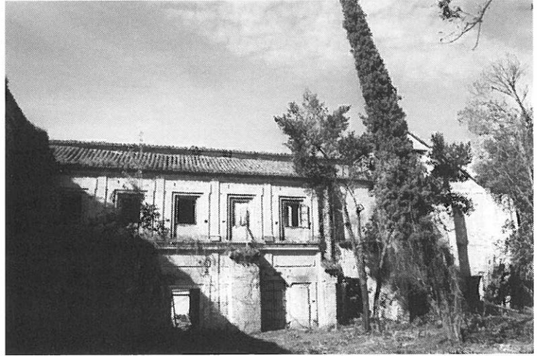
6. Vista del frente occidental del Patio de los Cipreses.
