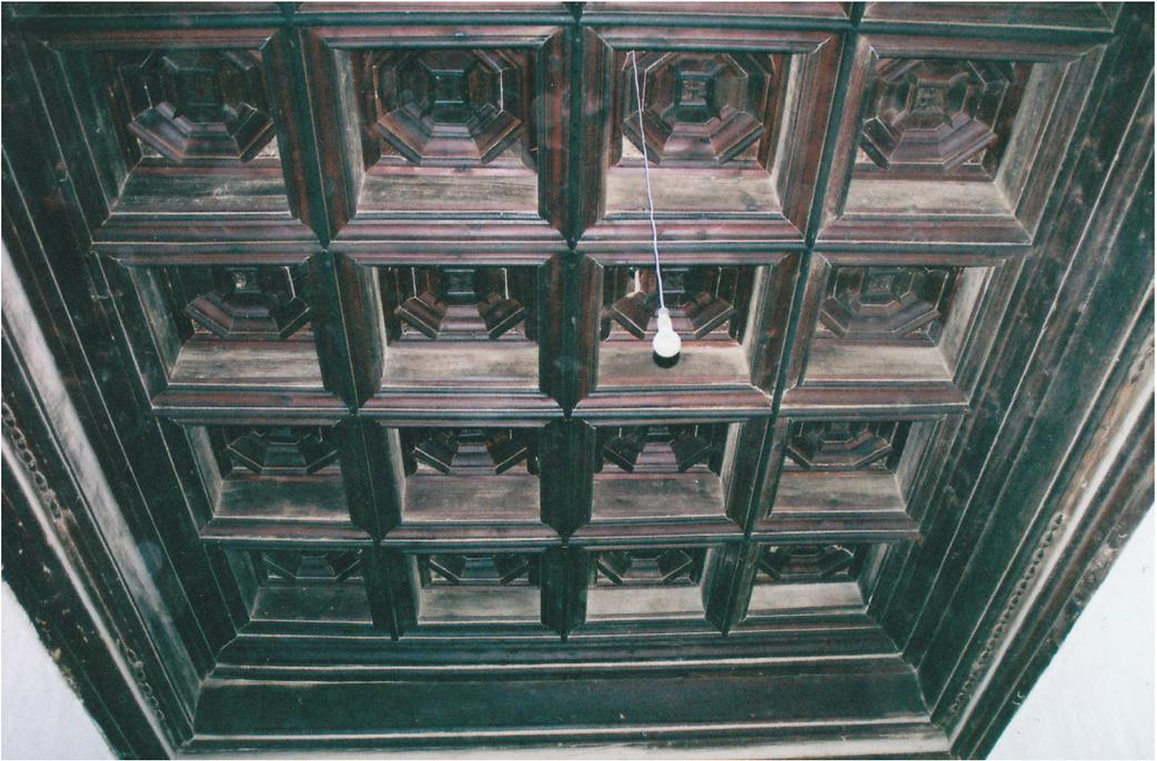
Fig. 7. Solución artesonada del Salón de la Justicia del castillo de La Calahorra (Granda). Fotografía del autor.
