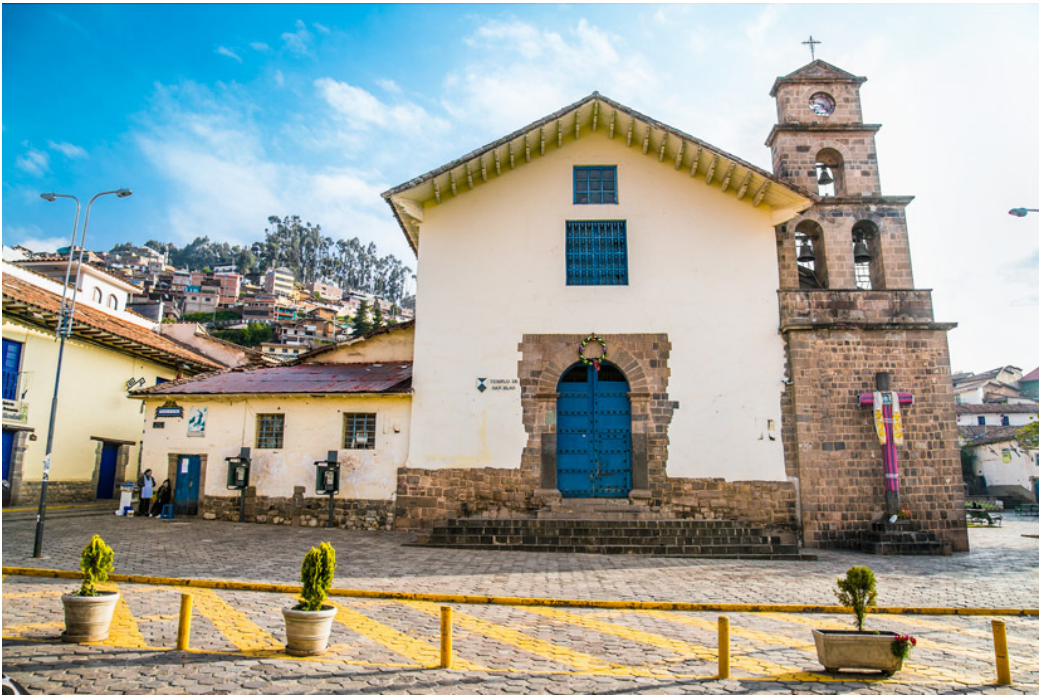
Fig.1. Exterior de la iglesia de San Blas, c.1650-1660. Cuzco.
