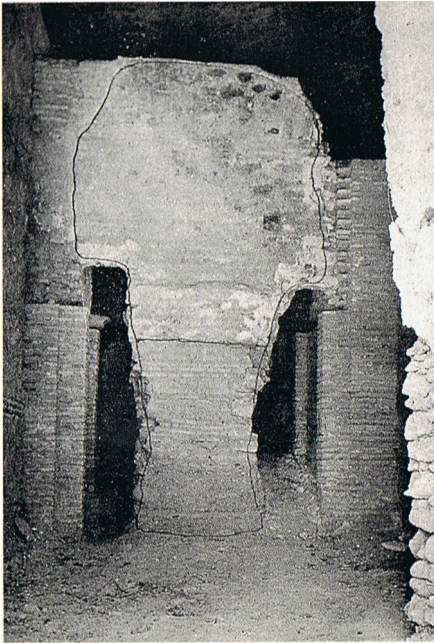
Fig. 7. Excavación de la Plaza de los Aljibes. Restos de la Puerta de la Tahona. (J. Bermúdez Pareja.1952-1953. Publicada en 1953).
