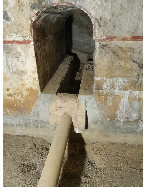
Fig. 16. Atarjea de entrada del agua de la acequia Real a la torre intermedia de la barranquera, y al aljibe de Tendilla. (C. Vílchez. 2024).
