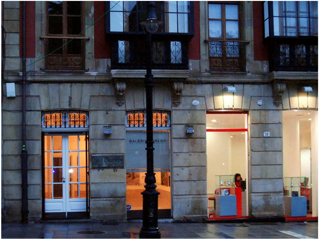
Fig. 1. Fachada del local que ocupó la Galería Durero, Gijón. Fotografía del autor.
