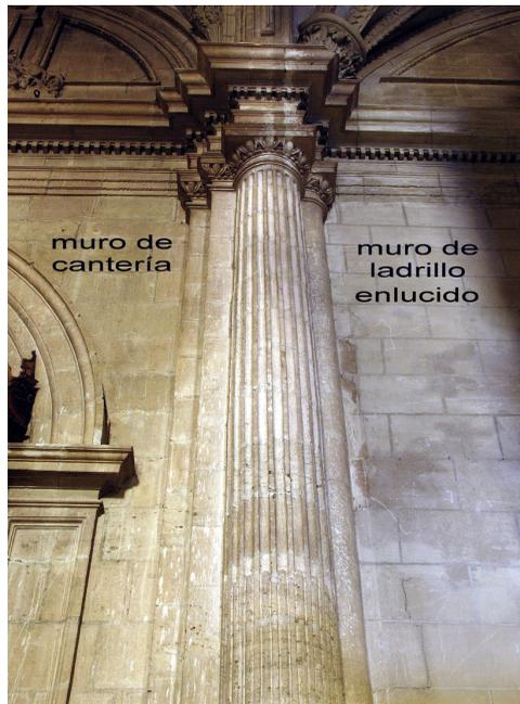
4. Pilastra del encuentro del tramo barroco con el gótico, con doble retropilastra angular y muro de cantería, a la izquierda, y baquetón curvo y muro de ladrillo enlucido a la derecha.
