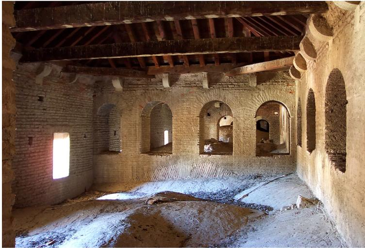
5. Vista del trasdós de las bóvedas, pared de ladrillo y cubierta, sobre el lado gótico.
