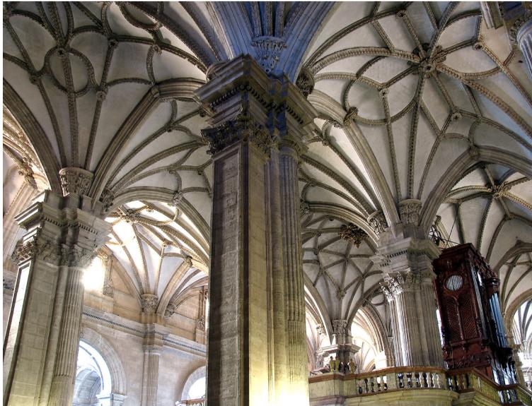
2. Interior de la catedral con la presencia de los contrafuertes de refuerzo en los pilares traseros y bóvedas góticas.
