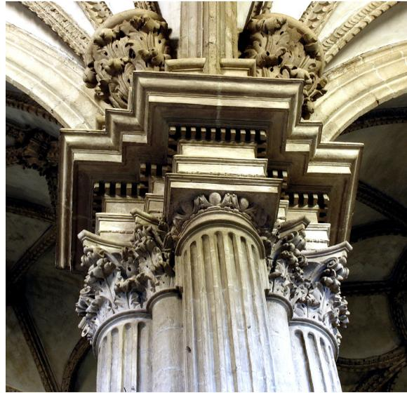
3a. Pilar del encuentro del transepto con la parte gótica. Doble diedro a izquierda y baquetón a derecha. 3b. Pilar del tramo gótico reformado, con doble baquetón como retropilastra.
