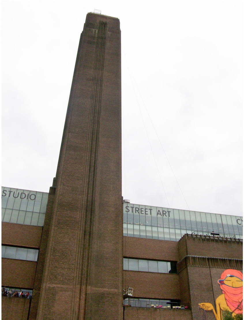
Fig. 5. Detalle de la antigua torre de la central térmica Bankside, hoy convertida en la Tate Modern, Londres. Fotografía de la autora.
