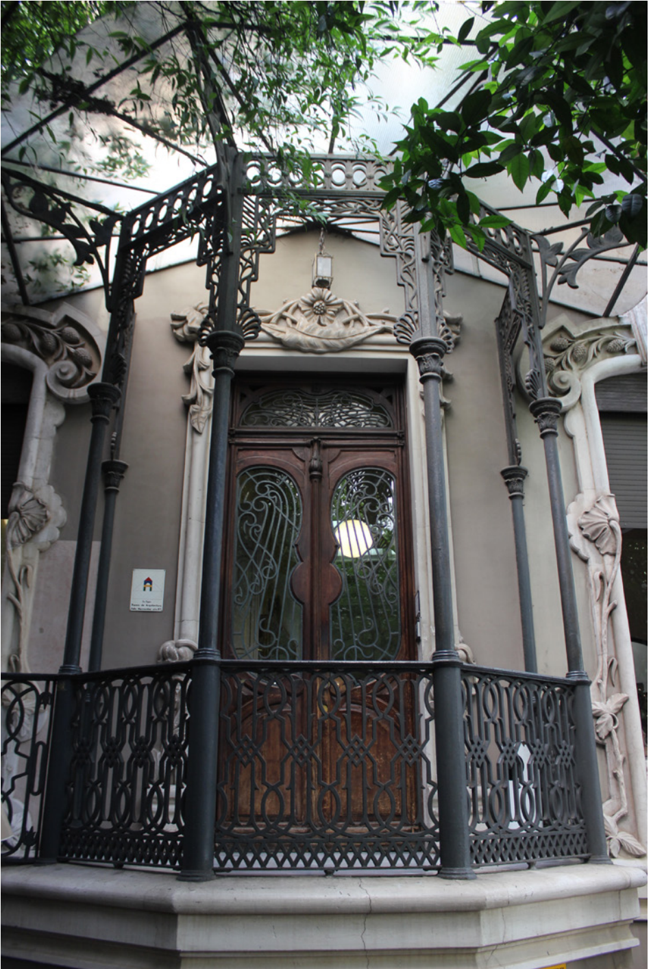
2. Estado Actual. Pérgola de acceso a planta principal, Palacete Teófilo Álvarez Cid, Avda. Gran Capitán, nº32. Córdoba. Fotografía realizada por la autora.
