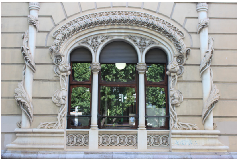
1. Estado Actual. Detalle de Fachada Palacete Teófilo Álvarez Cid, Avda. Gran Capitán, 32 (Córdoba). Fotografía realizada por la autora.
