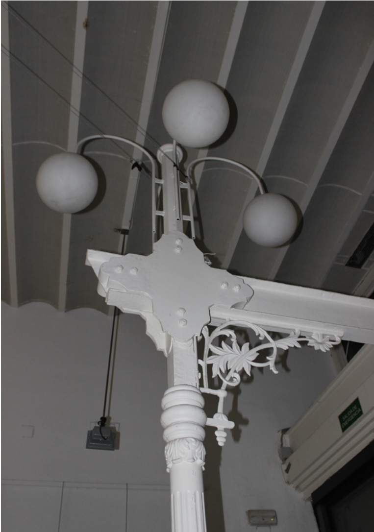
7. Detalle Pilar de fundición. Intervención Remodelación Juan Serrano (1985). Fotografía realizada por la autora.
