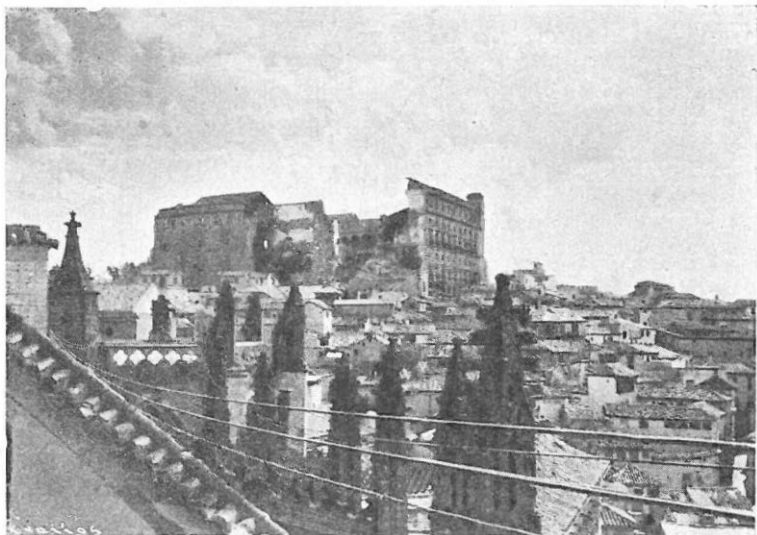
ABATIDAS SUS TORRES, DESHECHAS SUS FACHADAS, DESTRUÍDO SU PATIO, ESTOS SON LOS MUROS QUE QUEDAN EN PIE DEL FAMOSO ALCÁZAR TOLEDANO.
