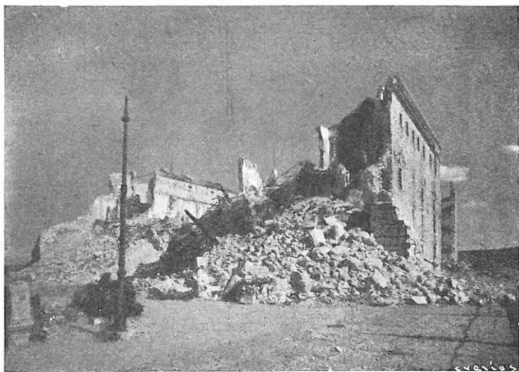
DE LA FACHADA N., LA PRINCIPAL DEL ALCÁZAR, OBRA DE COVARRUBIAS, Y DE LA PORTADA DE JEGAS, NO QUEDAN MÁS QUE ESOS MONTONES DE ESCOMBROS.
