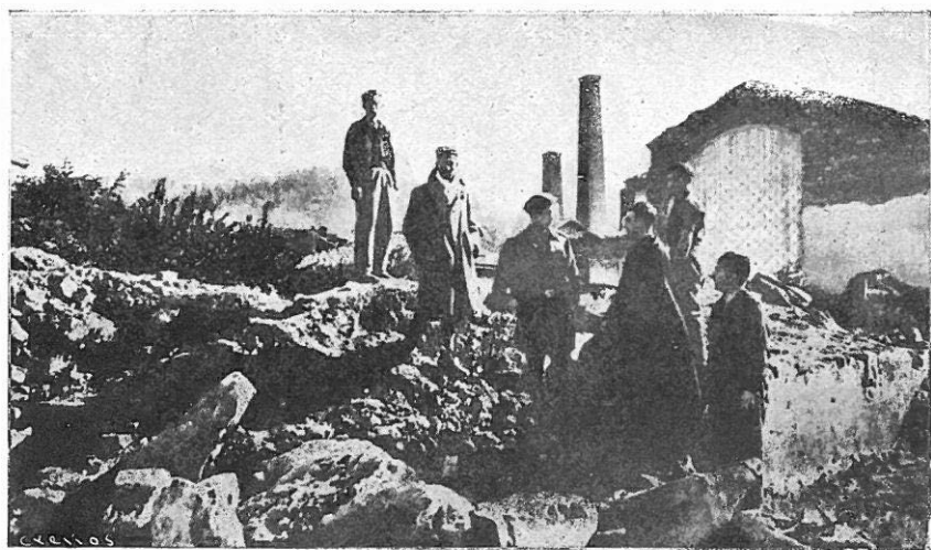
LA FELGUERA (ASTURIAS).—LAS RUINAS DE LA IGLESIA PARROQUIAL, ASIMISMO DESTRUÍDA EN 1936.
