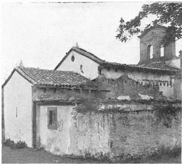
FUENTES-VILLAVICIOSA (ASTURIAS).—EXTERIOR DE LA IGLESIA DE SAN SALVADOR (1023) EN SU ESTADO ACTUAL. DESTRUÍDA POR INCENDIO.
