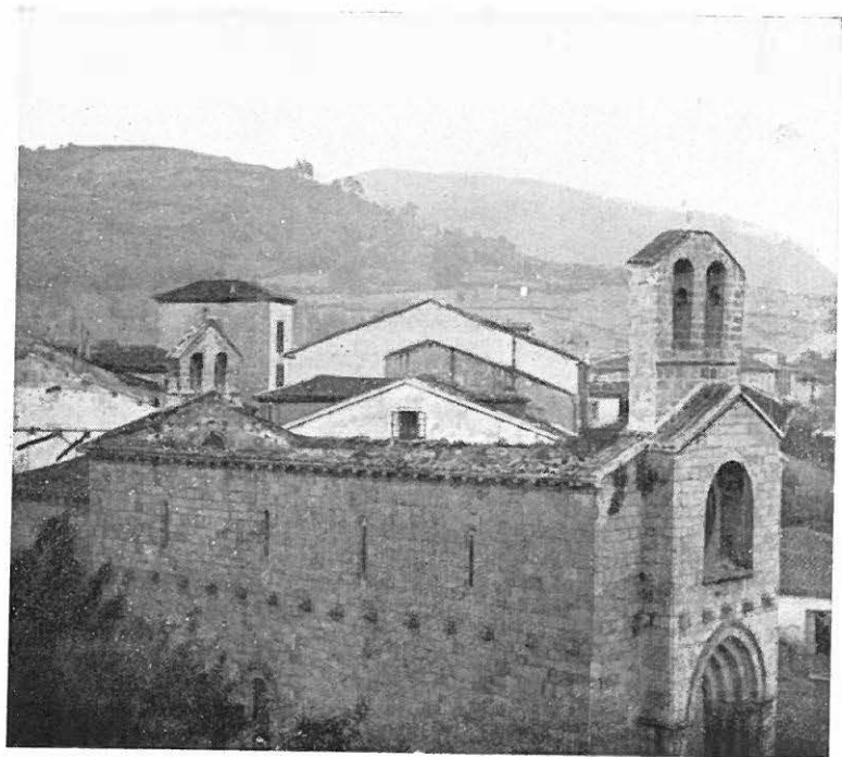
VILLAVICIOSA (ASTURIAS).—EXTERIOR DE LA IGLESIA DE SANTA MARÍA EN SU ESTADO ACTUAL. DESTRUÍDA POR INCENDIO.
