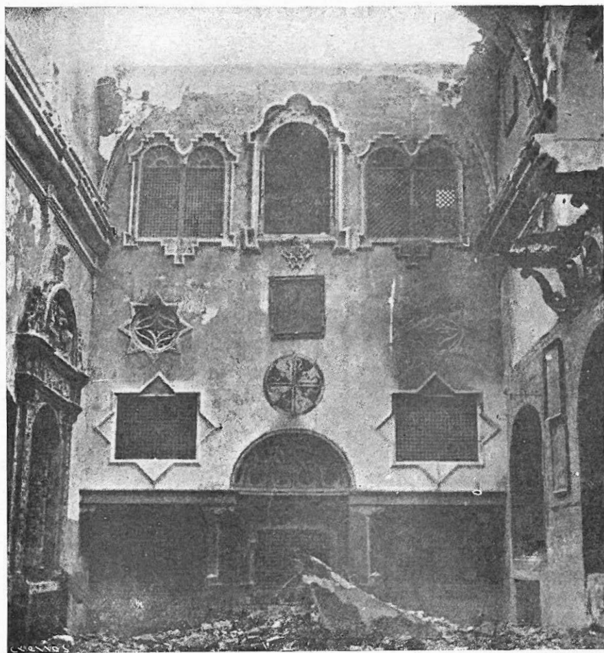
BAENA (CÓRDOBA).—INTERIOR DEL CONVENTO DE LA MADRE DE DIOS, DESTRUÍDO POR LOS MARXISTAS EN 1936.
