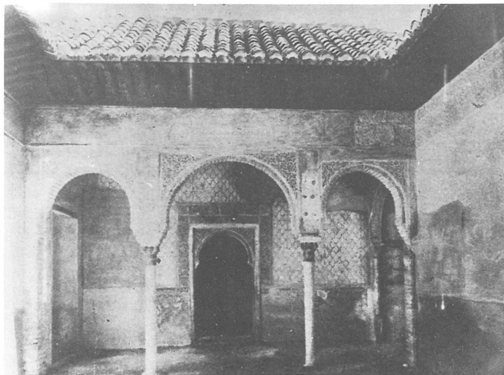
Fig. 9. El pórtico del Patido del Harem entre 1914 y 1923. Estado en que quedó al suspenderse las obras de consolidación en abril de 1914, hasta las Torres de Albás.
