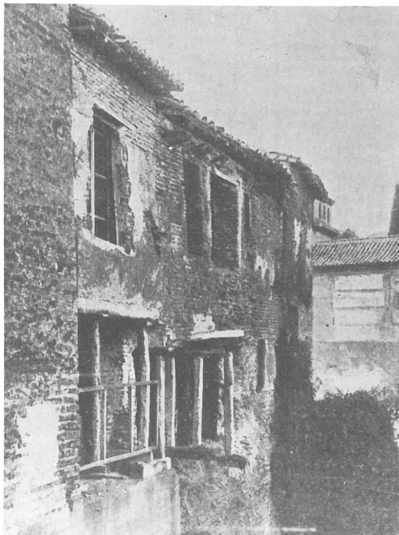
Fig. 17. Fachadas de las tres casas del Partal en 1916 antes de que se hundieran unos muros apuntalados en la de Villoslada.
