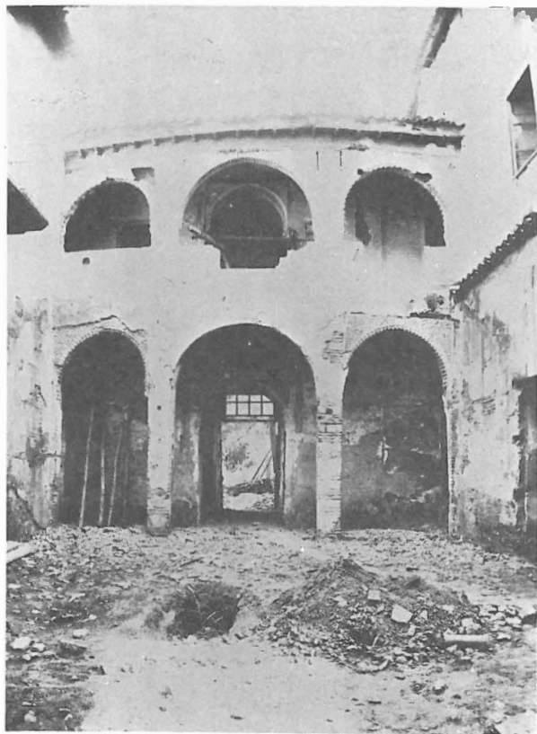
Casa de los Infantes. Restos árabes descubiertos al tiempo del derribo.
