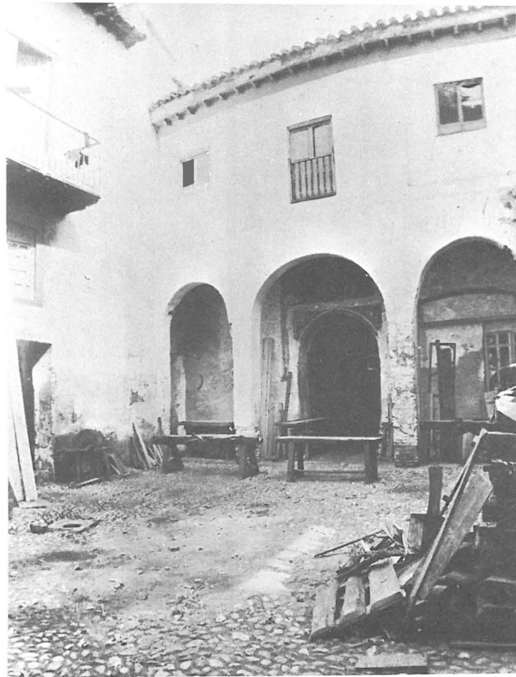
Casa de los Infantes. Parte árabe del patio antes del derribo.
