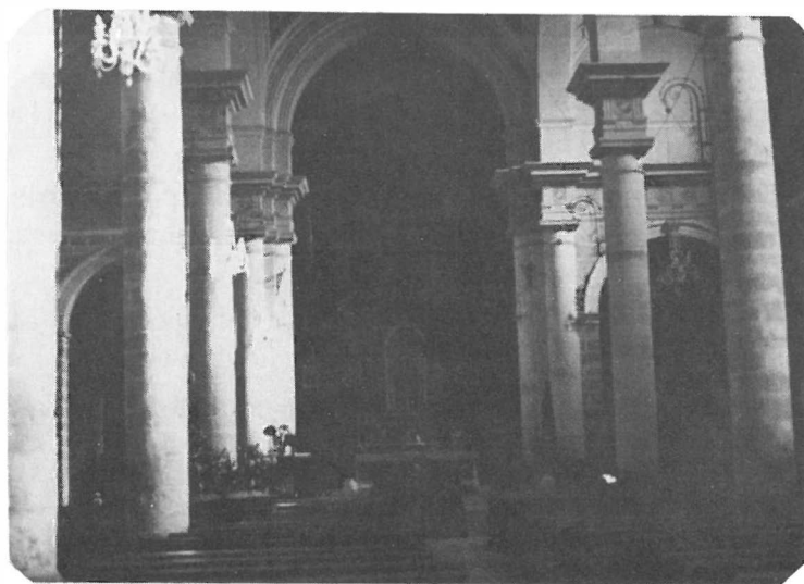
Interior de la Parroquia de San Juan Evangelista de Mancha Real.
