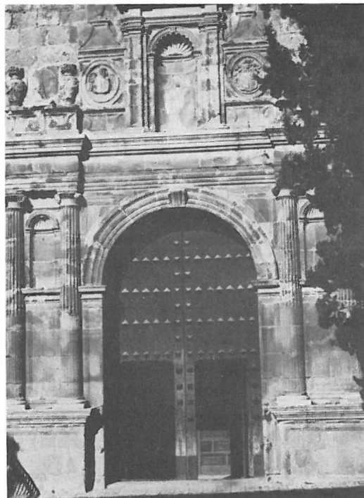
Fachada lateral de la Iglesia parroquial de San Juan Evangelista de Mancha Real.
