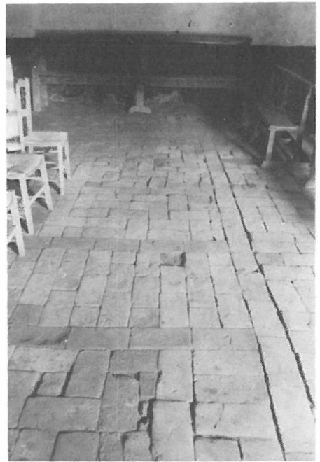
Cortes de Guadix. Suelo de ladrillos de rasilla.
