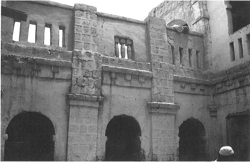
Casa de Tombuctú N.1. Patio.
