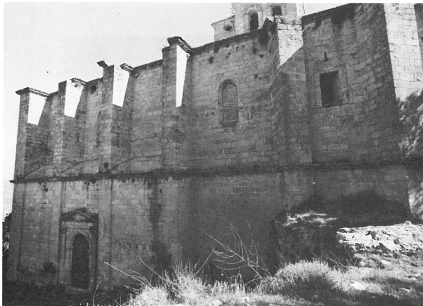
Lám. XI: Iglesia de la "Villa". Fachada lateral.
