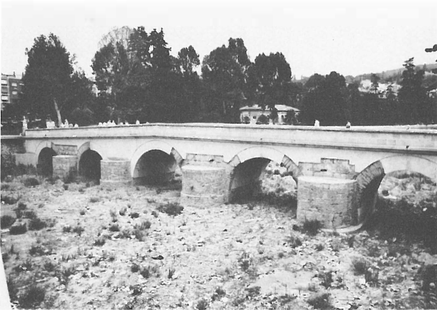
Lám. 8.- Puente ziri sobre el Genil tras la reforma de 1986. Aguas abajo.
