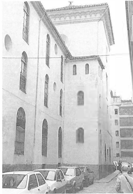
Exterior de la caja de escalera.
