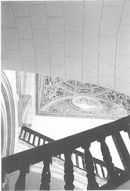
Vista de la escalera. En primer término los hocinos.
