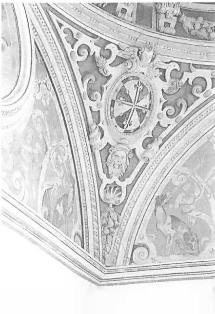
Detalle de los arranques de la bóveda.
