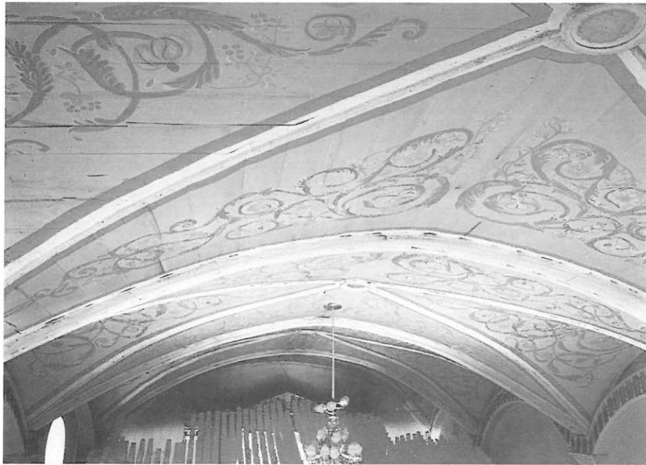
Fig. 7.- Ojo del Agua (Michoacan). Vista de la techumbre.
