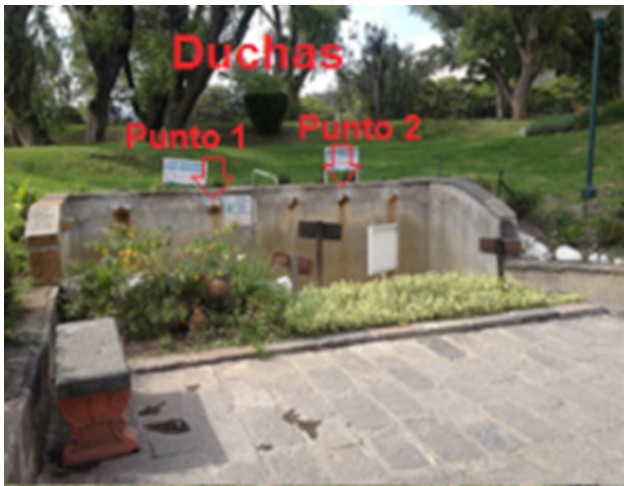
Figura 3. Fotografía de las duchas de agua termal del Balneario "El Tingo". Provincia de Pichincha, Ecuador
