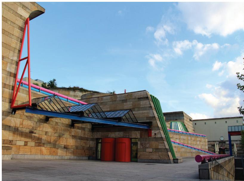
FIG. 11. James Stirling y Michael Wilford, Neue Staatsgalerie, Stuttgart, 1977-84 . Vista de la entrada. Procedencia de la imagen: Wikipedia Commons. Autor: Fred Romero. Dirección web: https://commons.wikimedia.org/wiki/File:Stuttgart_-_Neue_Staatsgalerie_(35736927202).jpg?uselang=de .
